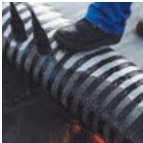
Schnelle Verarbeitung durch streifenweises Spezialbitumen.
