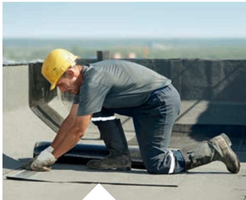
Begleitung auf der Baustelle mit Lehrverleger (Einweisung von Verlegetechniken vor Ort)
