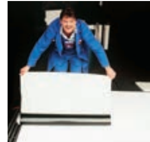
Aufkleben der Bahn bei gleichzeitigem Abziehen der unterseitigen Folie
