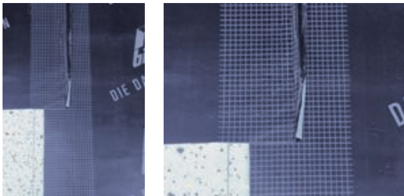
Ausrichten der Bahnen mit Hilfe des Karo-Rasters
