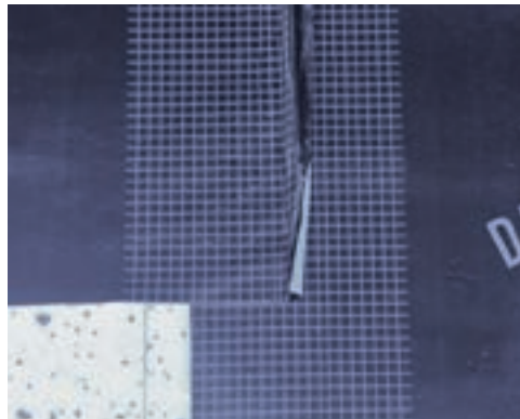
Ausrichten der Bahnen mit Hilfe des Karo-Rasters
