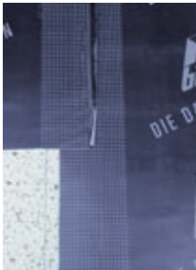
Ausrichten der Bahnen mit Hilfe des Karo-Rasters
